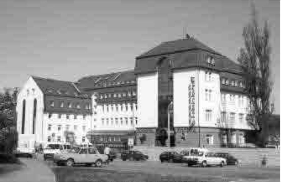
Neue Post am Hauptbahnhof
