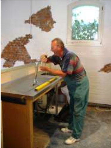
Die Theke, die wird jetzt montiert Perkunos, der ist fasziniert Öffnet den Hahn - ist sehr verdrossen: „Ach so, noch gar nicht angeschlossen!“
