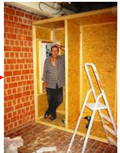
Das Grundgerüst, das steht ganz fix Im Innern lauert Rt. Strix
